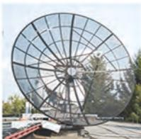
СПОИ-Э – станция приема и обработки данных с геостационарных КА серии Электро-Л в международном формате LRIT в L-диапазоне. Диаметр антенны 3 м.
